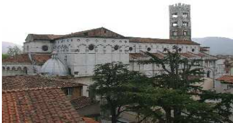
Figura 1: Vista del Duomo di San Martino (Lucca), dal tetto del Dipartimento
